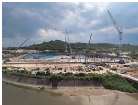
PC柱及び梁工事の様子
