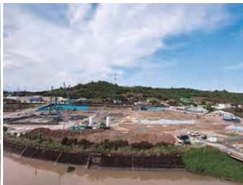
土壌整備の様子
